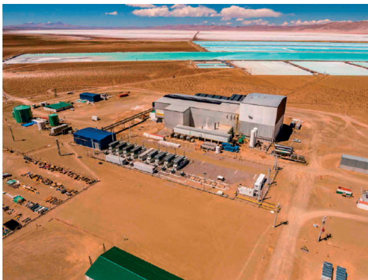
Figura 1. Vista panorámica del Proyecto Sales de Jujuy S.A. Fuente: https://salesdejujuy.com/projects/ .
