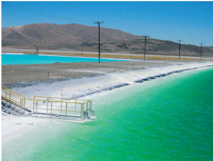
Figura 3. Piletones de decantación de salmuera. Proyecto Sales de Jujuy S.A. Foto: Nelly Vargas Rodríguez.
