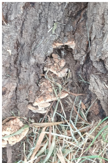
Figura 2: Daño de Fomes sp., en Salix sp., basidiocarpos desarrollados durante el otoño en el cuello de los árboles dañados.
